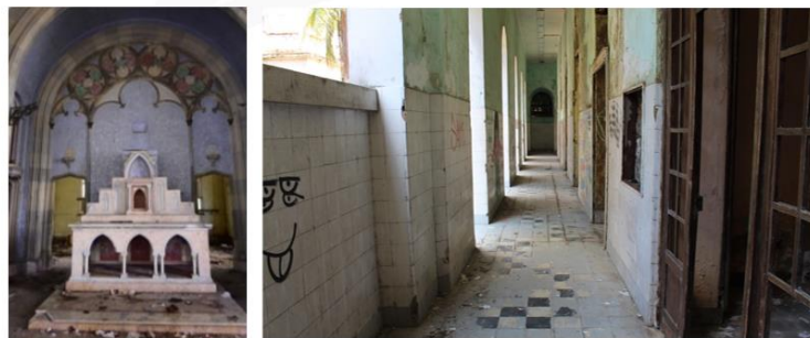
Figura 5 - Hospital Universitário. Antes da Aquisição.
